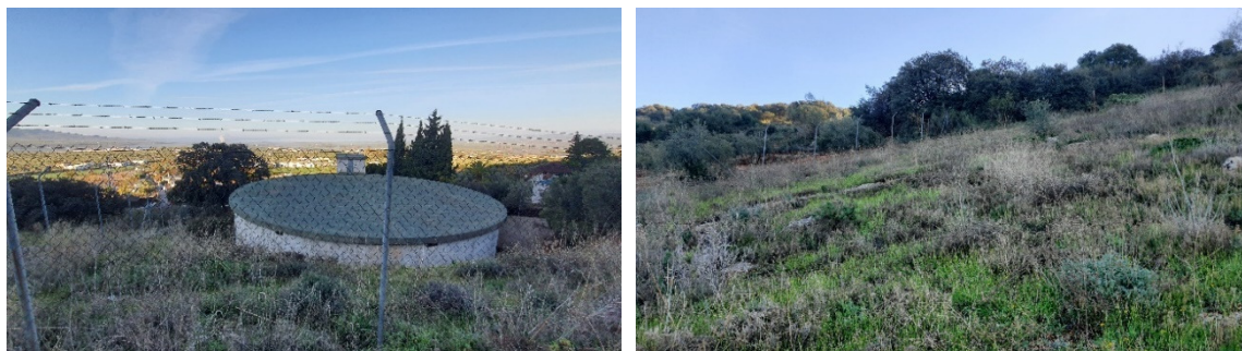
Depósito actual y Zona de ampliación para el Nuevo Depósito (imagen de la derecha)
